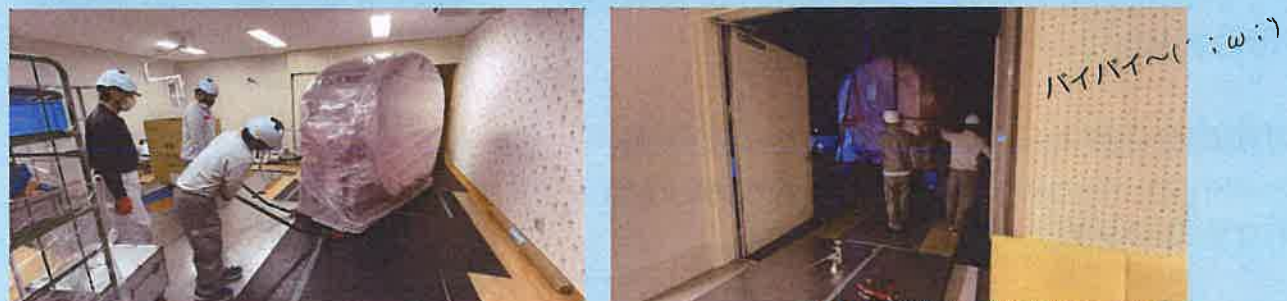
前のCT装置の搬出作業の様子
